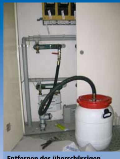
Entfernen des überschüssigen Dichtmittels mit Druckluft oder Stickstoff in den Ausblasebehälter.
