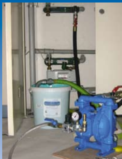
Befüllen der Leitung mit Prodoral R 6-1 mit der Membranpumpe.
