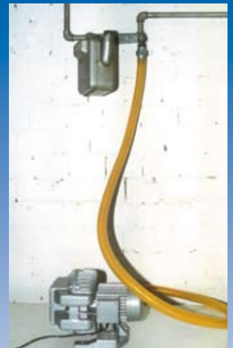
Trocknen der Leitung mit dem Gebläse.
