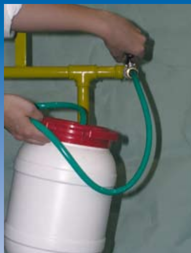
Entlüften der gefüllten Gasleitung an sämtlichen Gasentnahmestellen.
